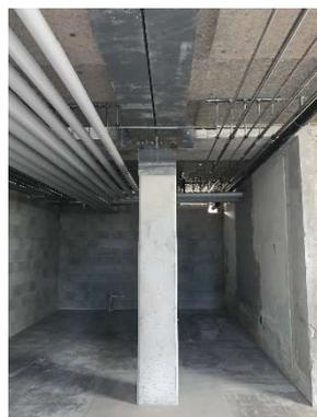
Renforcement sous dalle pilier et poutres métalliques
