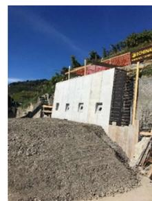
**6. Descriptif du projet** Mur béton armé ancré, longueur 95 m', hauteur moyenne 3.50 m', épaisseur 0.75 m', tirants d'ancrage Stahlton, longueur moyenne 40 m', maçonnerie de parement type mur de vigne
