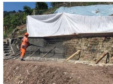
**8. Méthode d'exécution** Installation, gestion du trafic par feux de chantier, protection Seroc, campagne d'essais pour déterminer le toit de molasse, et la longueur des tirants d'ancrage, exécution en étape de 7 m' pour éviter l'activation du glissement, tant pour la paroi clouée que pour le mur en béton armé. Exécution de la maçonnerie type mur de vigne épaisseur 45 cm. Réfection de chaussée.
